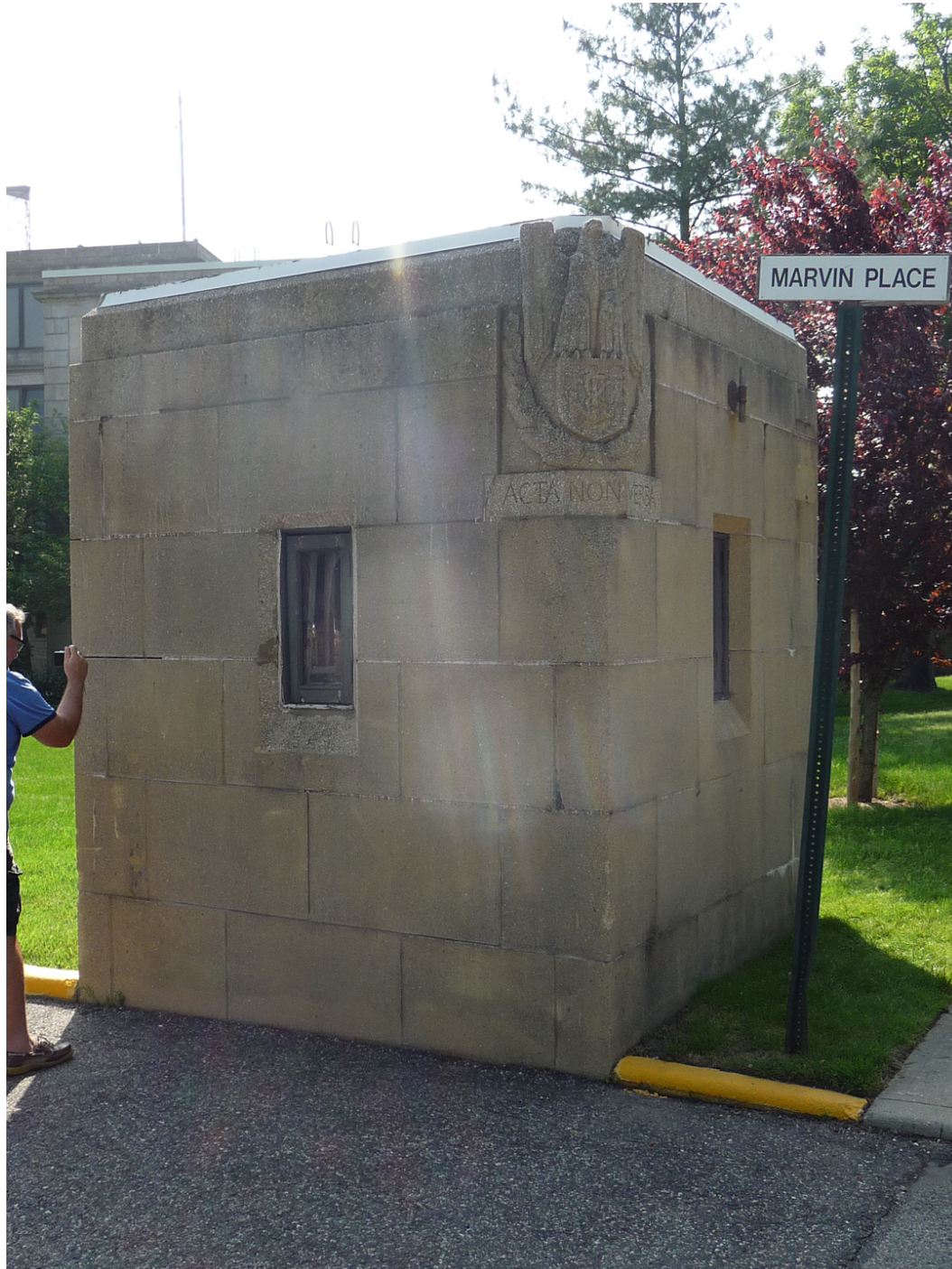
Figure 16. Marvin Place Gate (ERDC-CERL, 2015).
